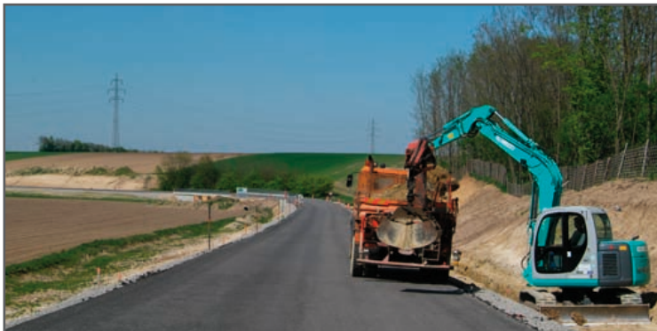
An den Nebenanlagen wie der Ableitung des Regenwassers entlang der Straße wird bereits seit Wochen gearbeitet.
